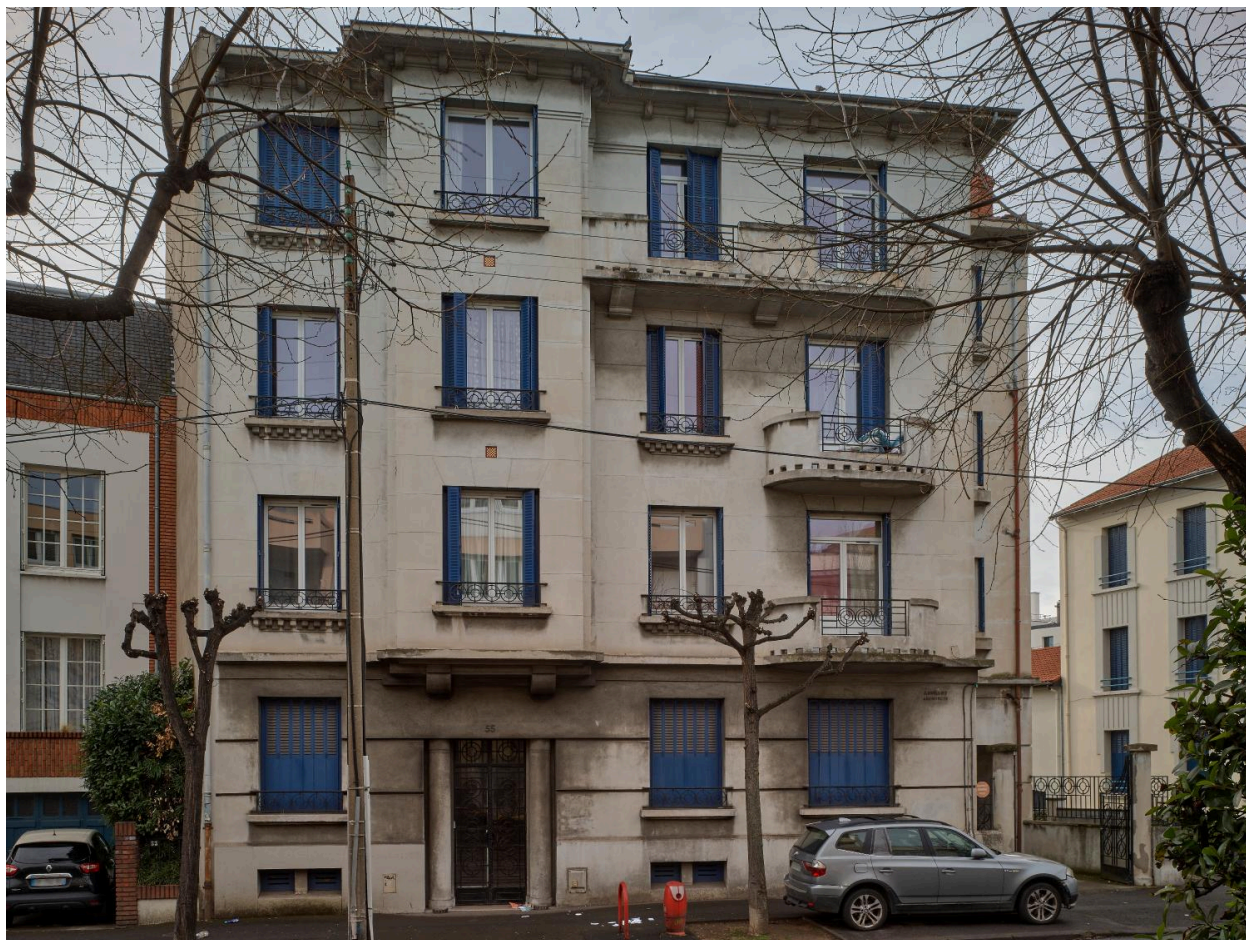
Façade sur le boulevard Jean-Jaurès
