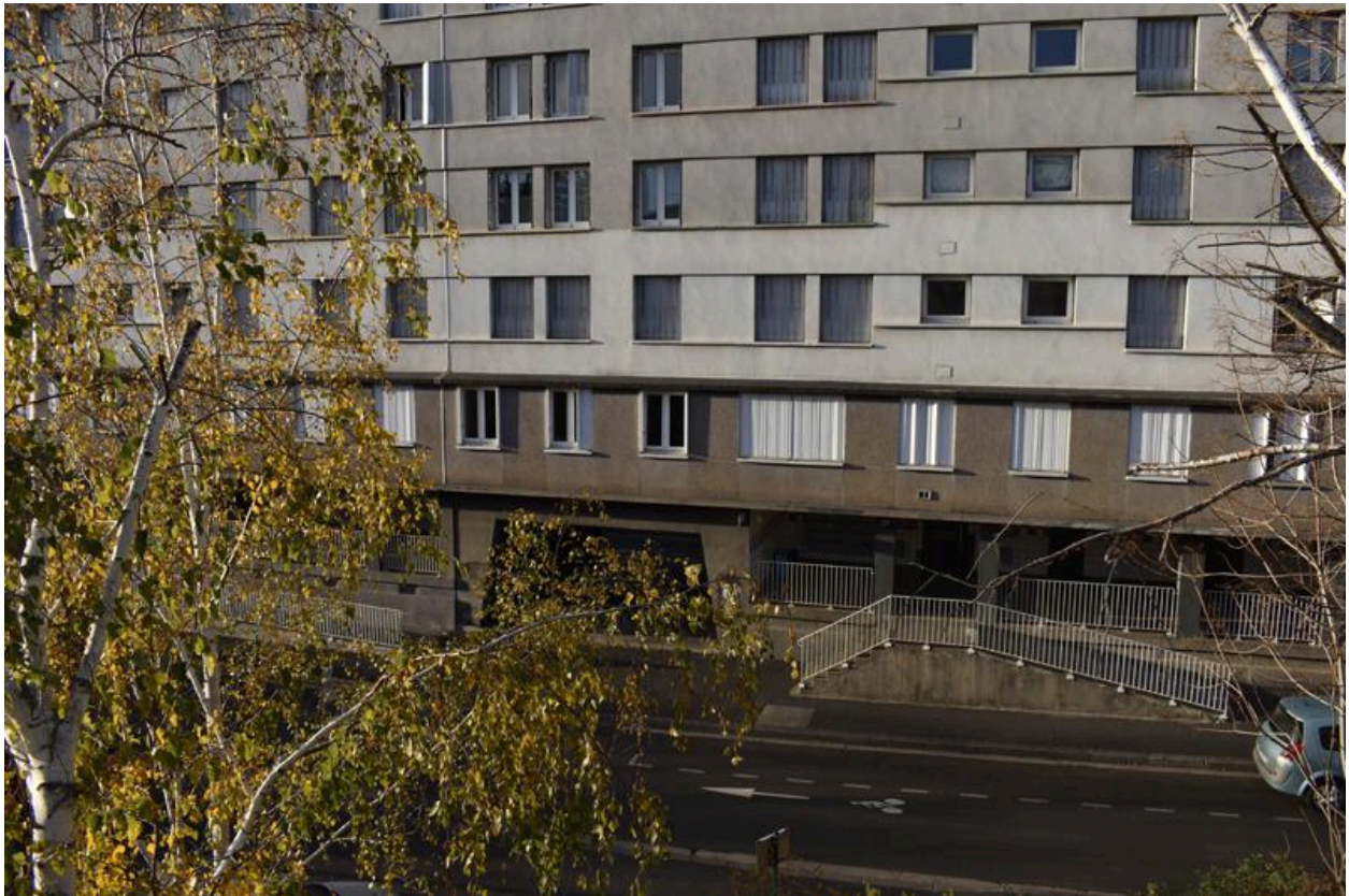
Façade sud. Aménagements d'accès à l'immeuble, vus depuis le contre-haut, au niveau du parvis de la crèche. (Photo chercheur.)
