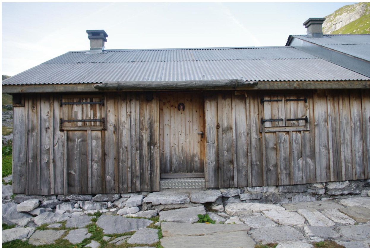
Vue de la façade antérieure sud
