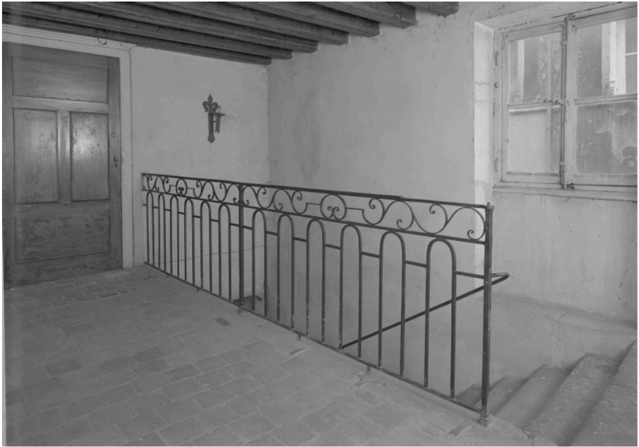
Garde-corps du 1e étage d'escalier.
