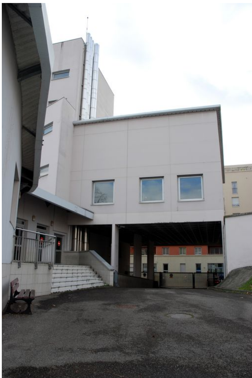
Bâtiment A : vue du passage couvert de la rue Claude-Veyron depuis la cour
