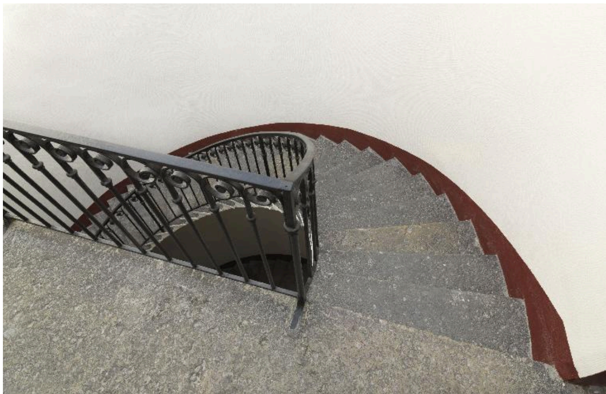
Vue de l'escalier depuis le palier
