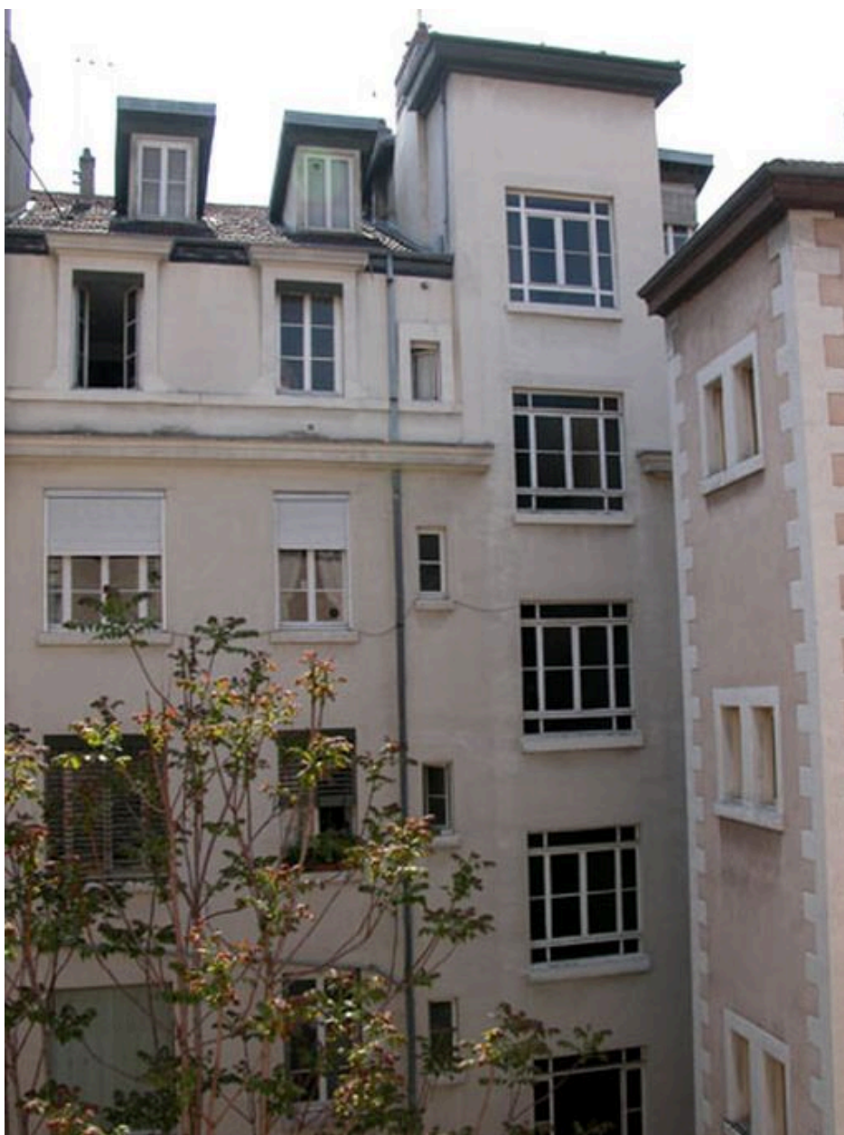
Elévation postérieure depuis le 1 rue Sébastien-Gryphe
