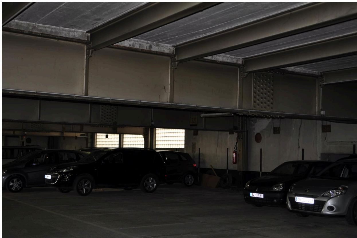
Vue intérieure du parking souterrain
