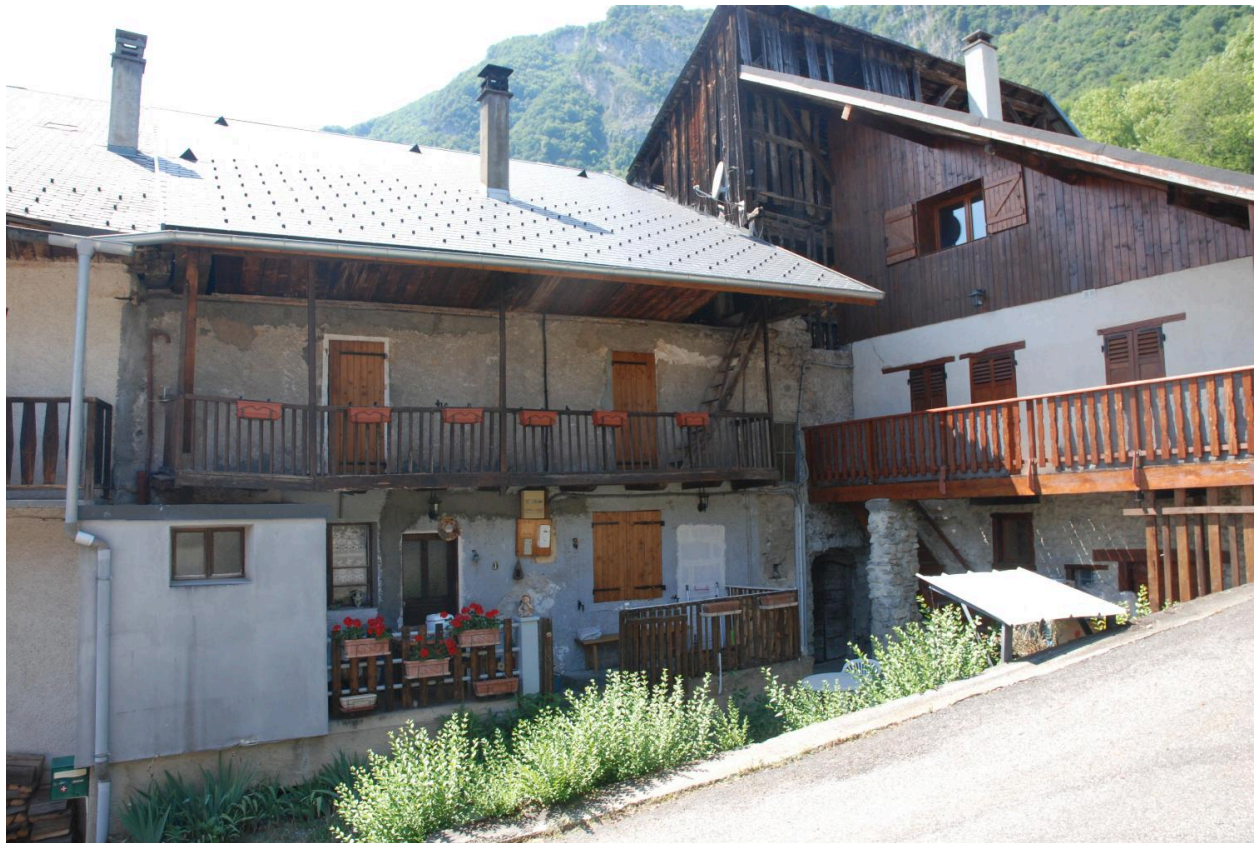
Maisons de vigneron (les Allues-dessous, 2018 YE 134 à 136).
