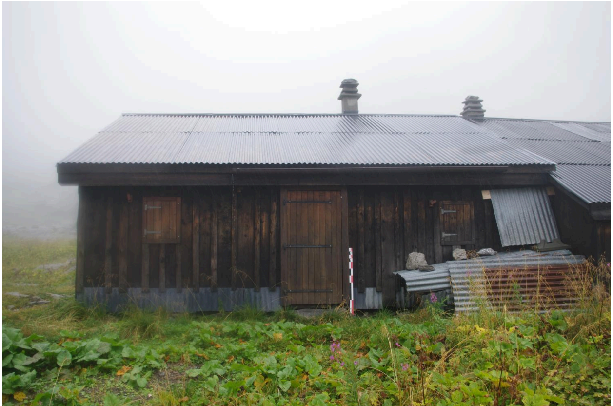
Vue de la façade postérieure ouest
