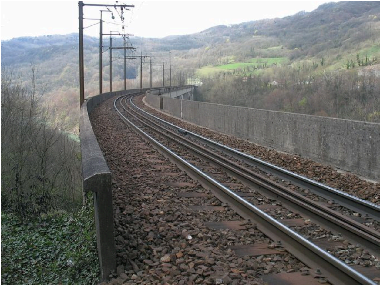
Vue sur le tablier : voie ferrée
