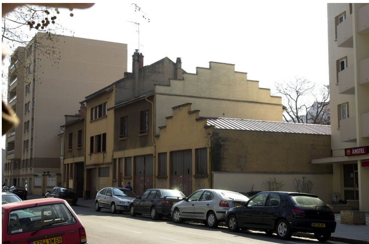
Vue générale, côté droit
