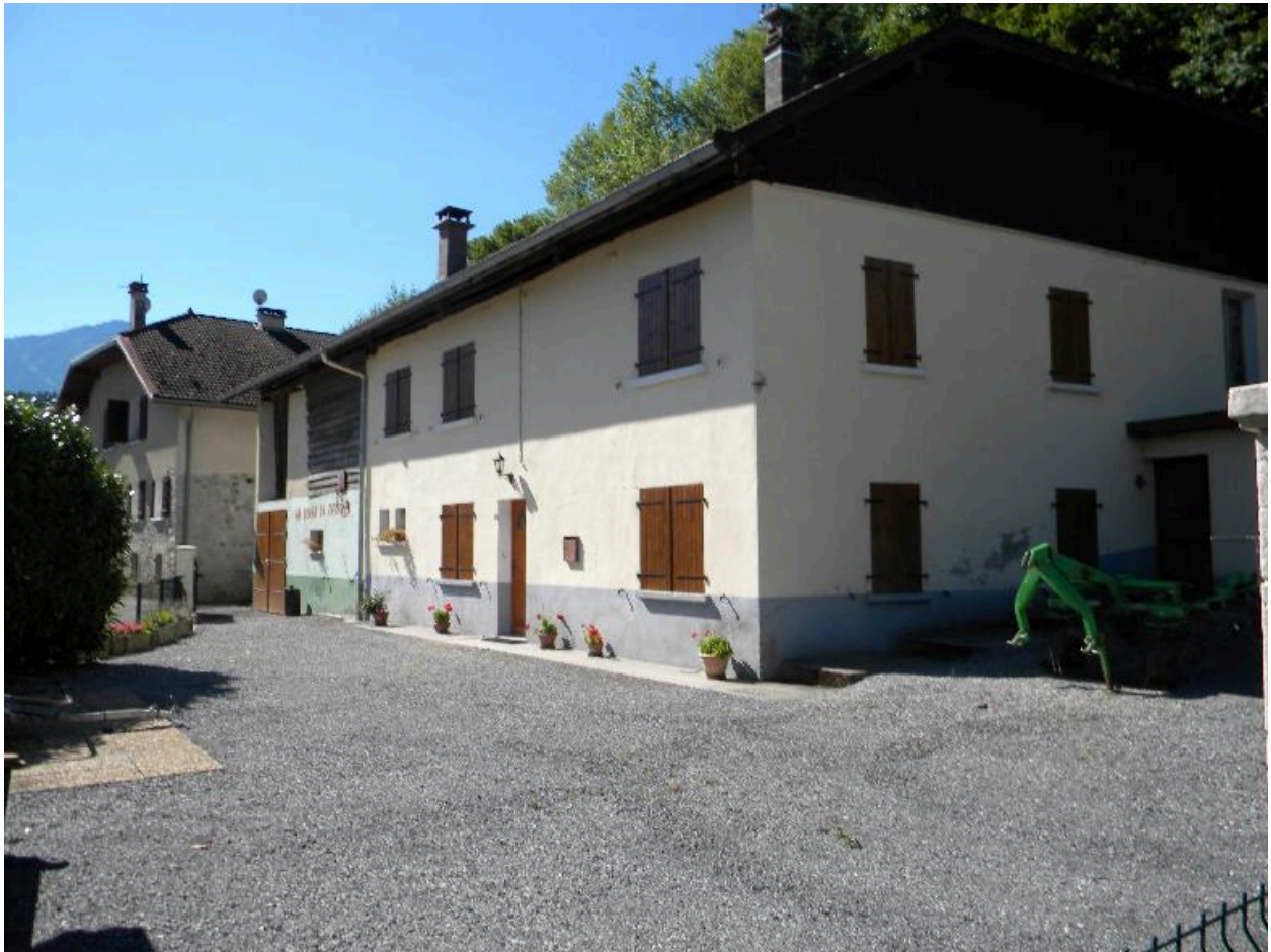
Vue d'une ancienne ferme modifiée (2008 F3 479)
