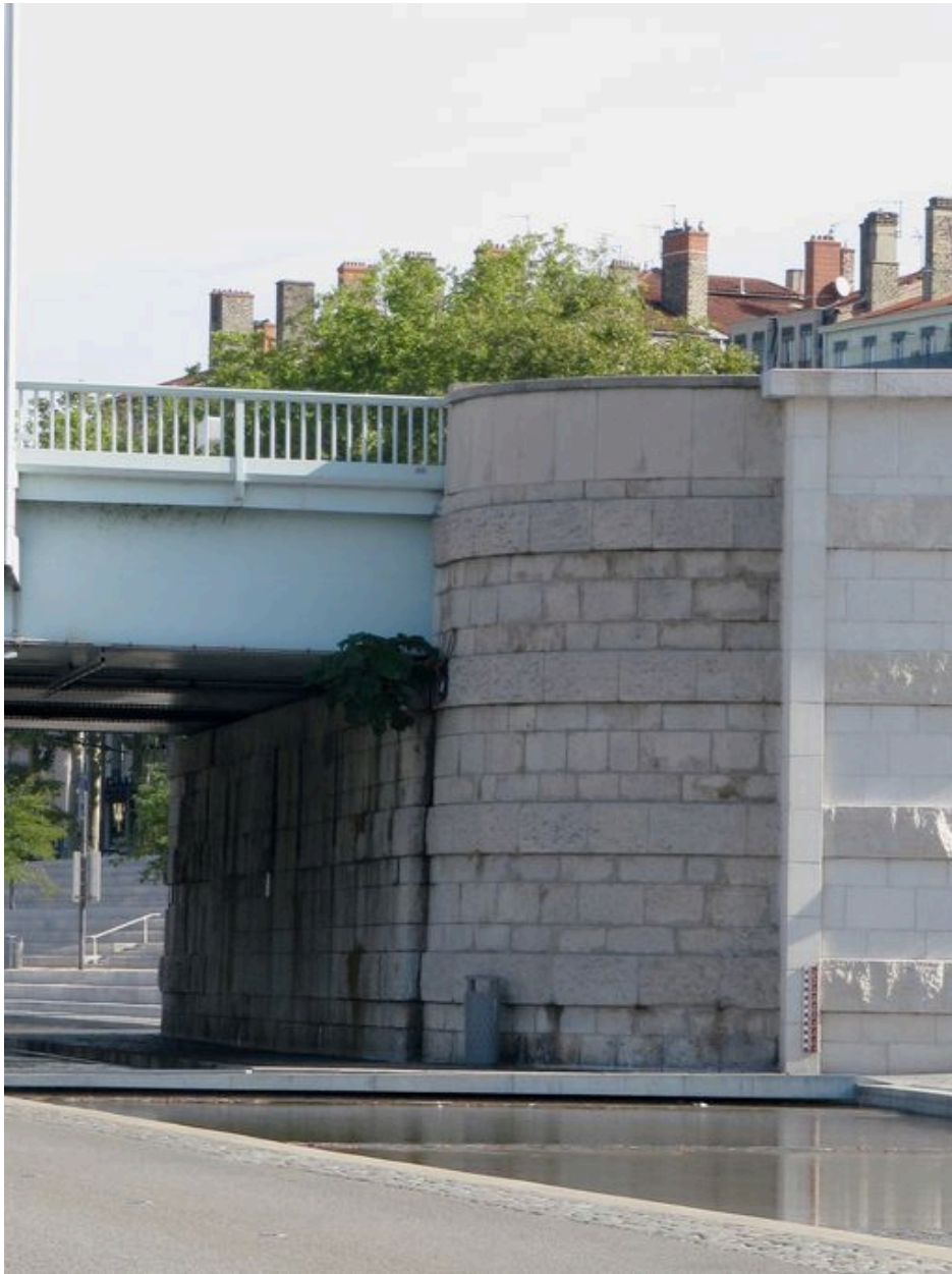
Culée gauche, face aval, vue générale (depuis la rive gauche)
