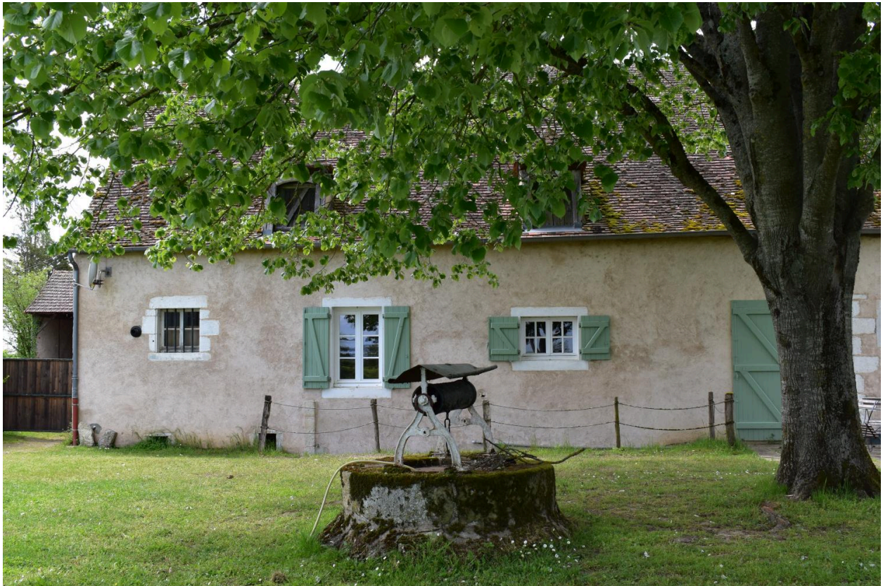
Détail de la façade orientale de la maison d'habitation et du puits.
