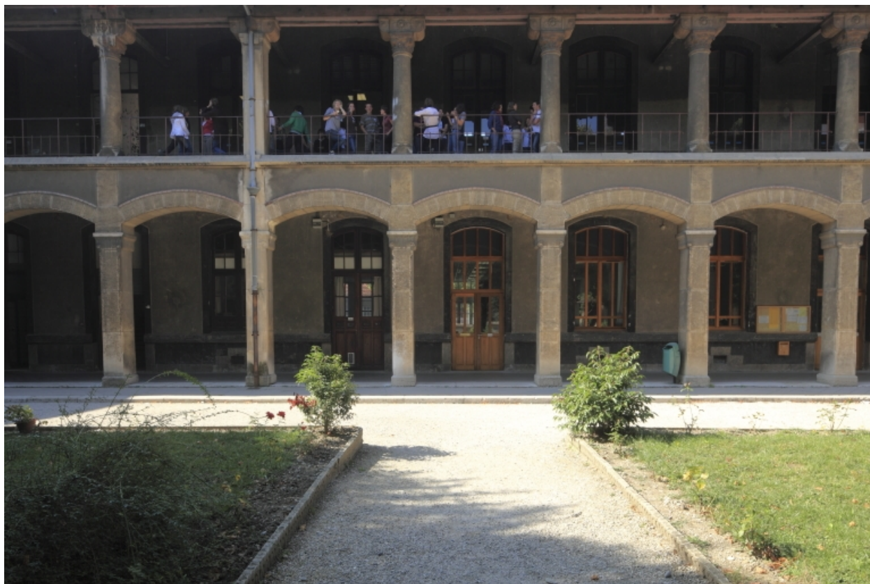
Cour H. Entrée de l'administration.
