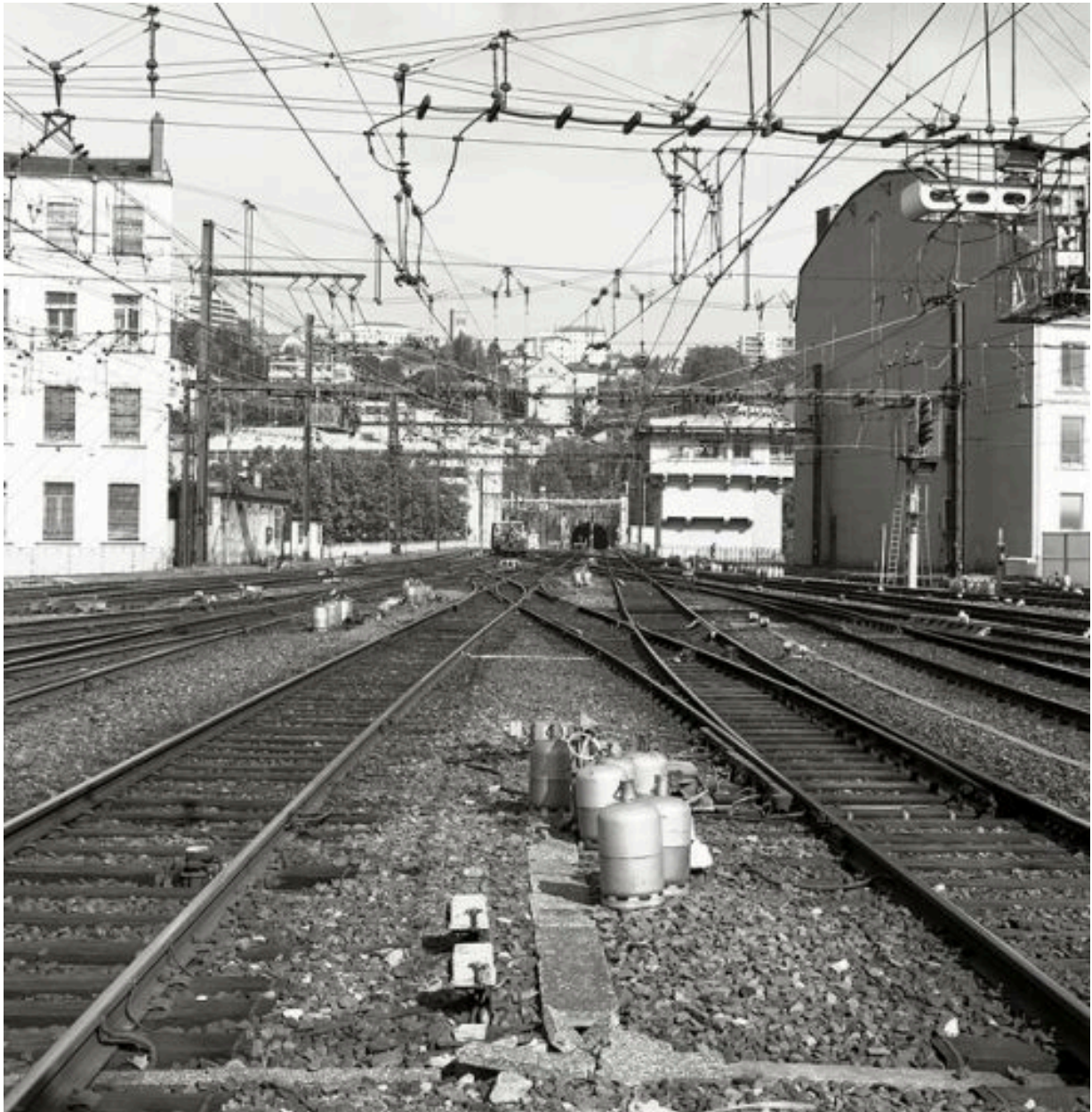
Vue d'ensemble des voies vers l'ouest et de l'entrée du tunnel Saint-Irénée
