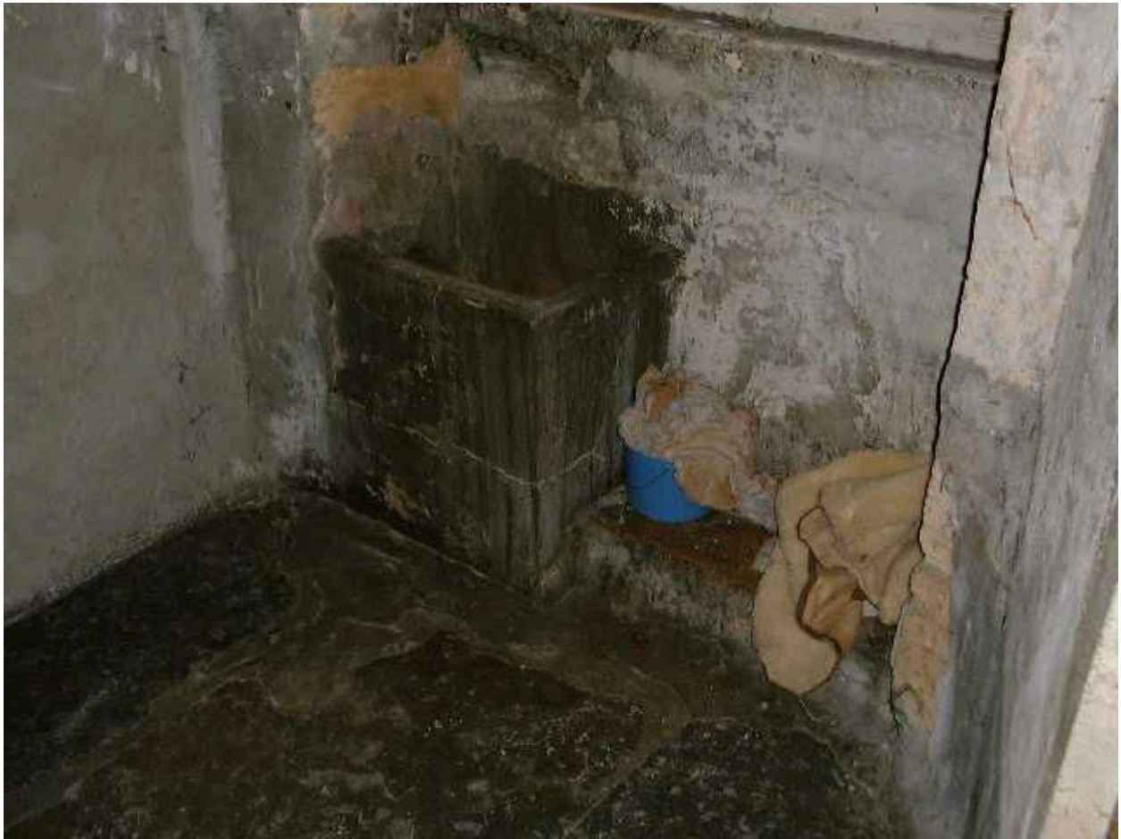
Le lavoir en pierre sur le pallier de l'escalier menant aux combles
