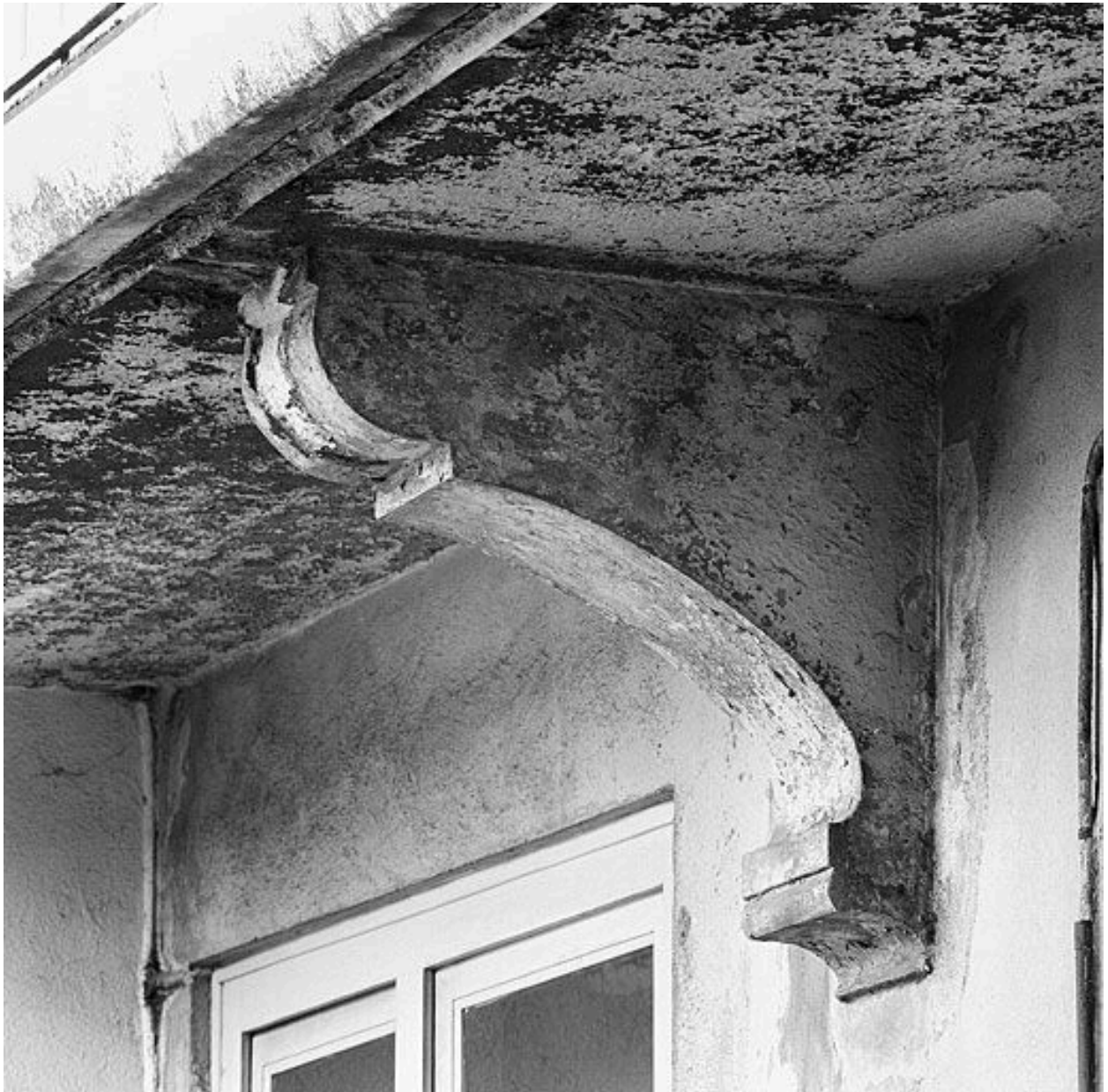
Détail d'une console soutenant une coursière, corps de bâtiment sud
