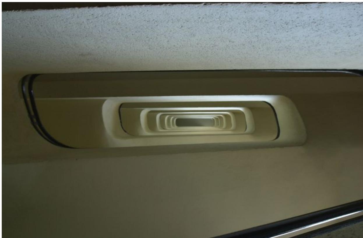
Vue de la cage d'escalier
