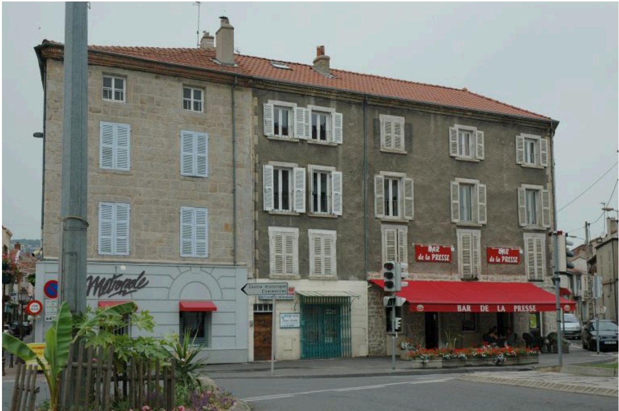
Vue de l'élévation latérale depuis le boulevard Carnot.
