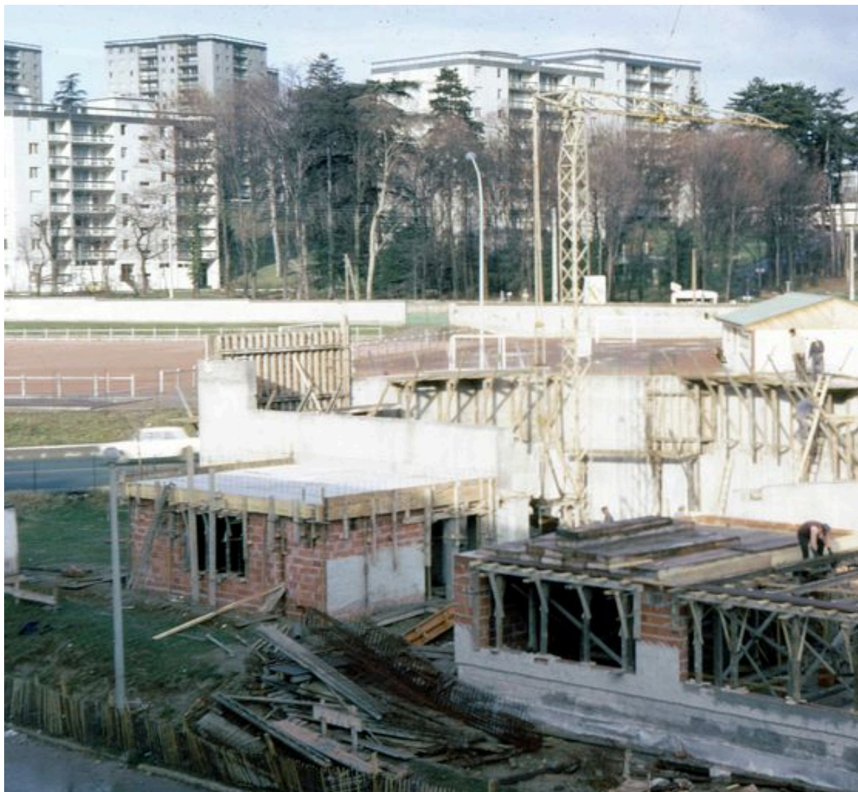
Construction des salles de catéchisme et de la sacristie
