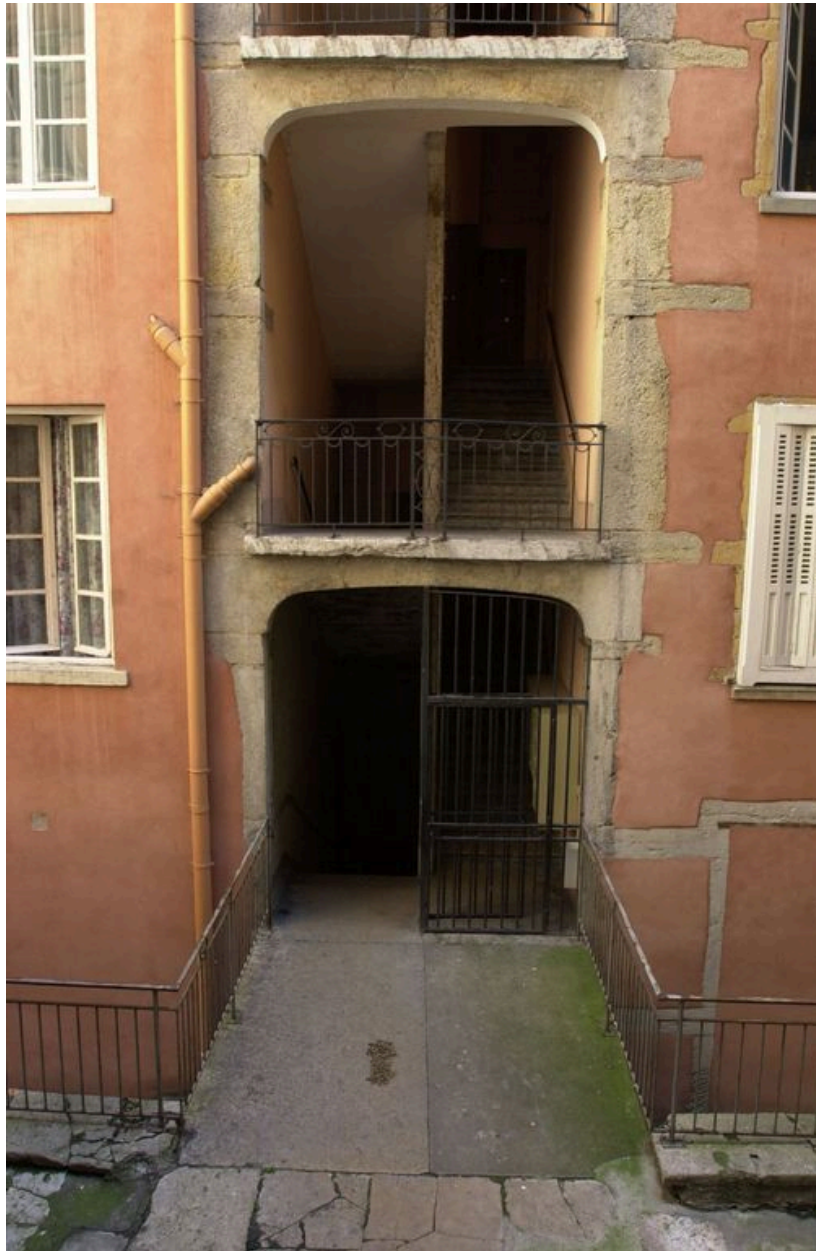
Vue de l'escalier en fond de cour du 14 rue Leynaud
