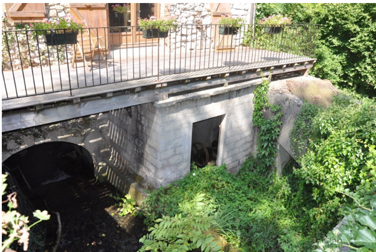
Vue de l'emplacement réservé au moteur hydraulique
