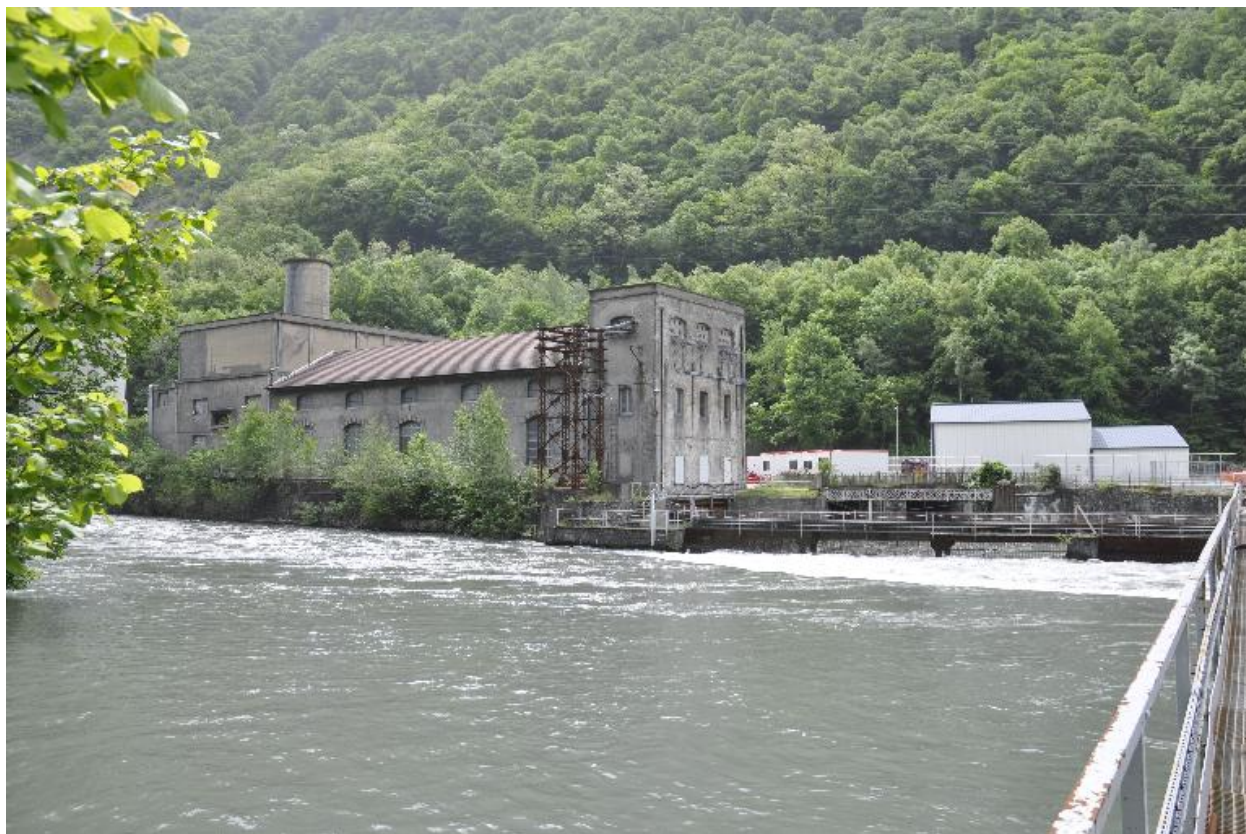
Vue de la centrale
