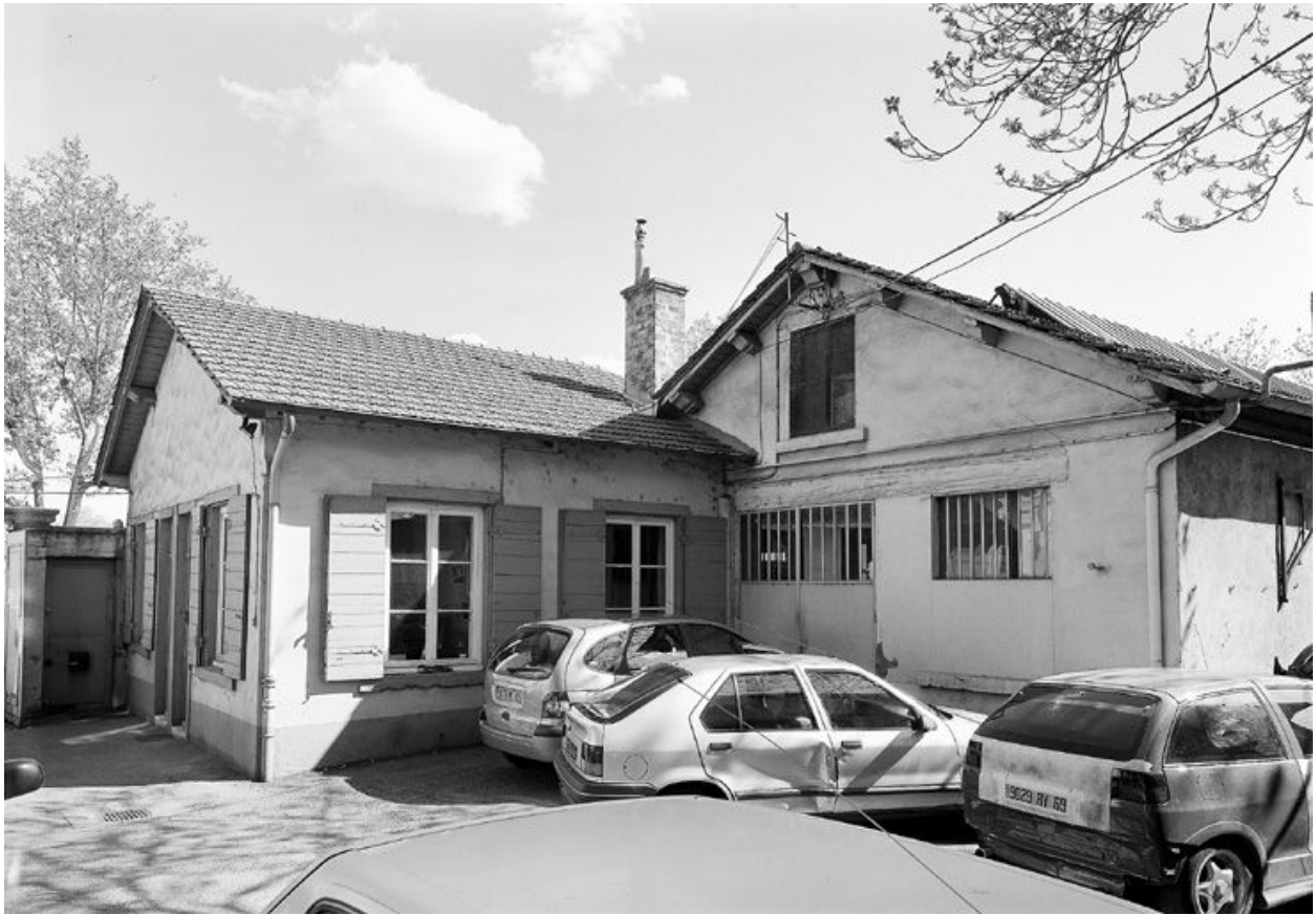
Cour de la fonderie vue ouest, bureau et ateliers
