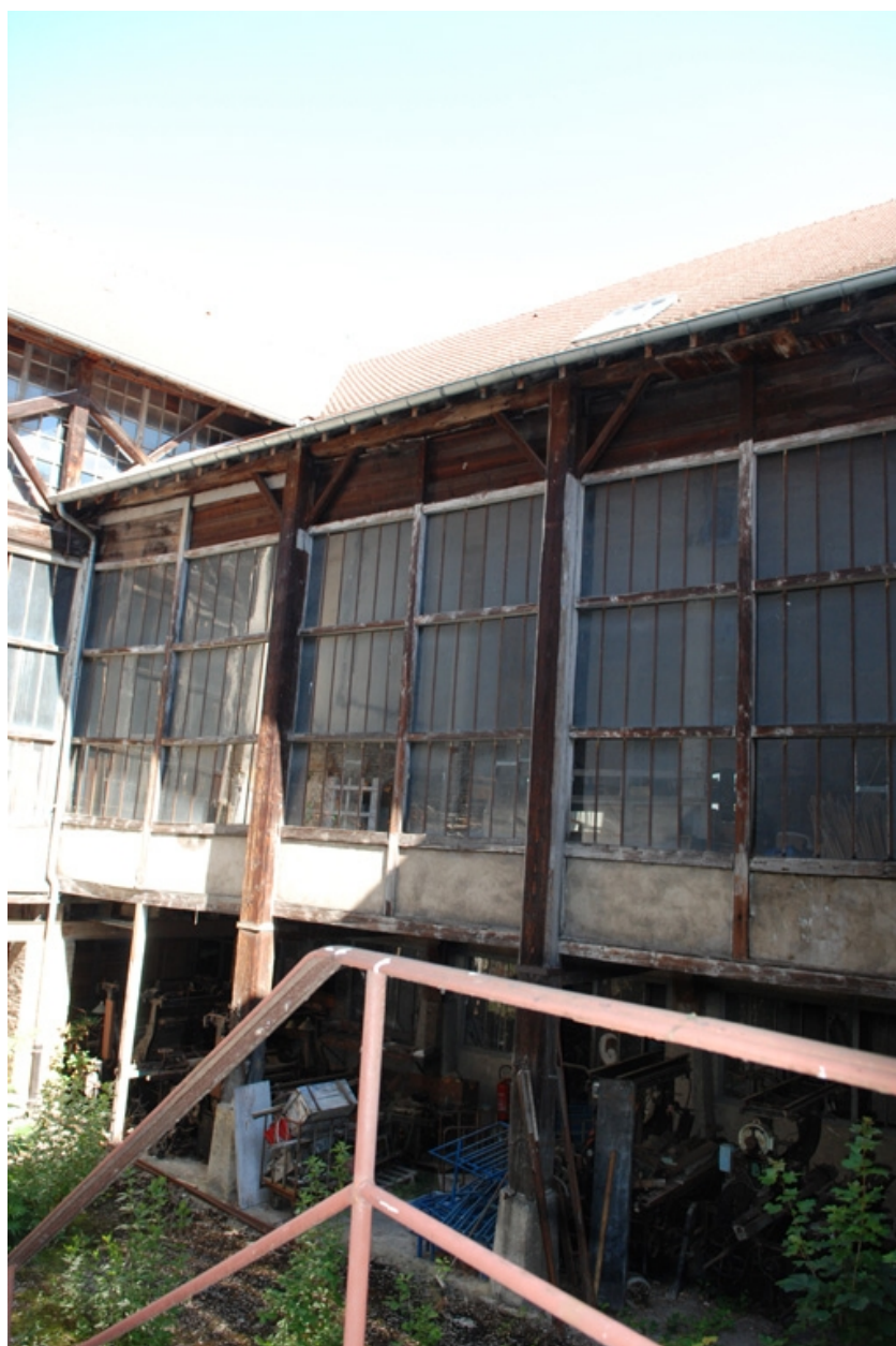
Vue extérieure atelier de menuiserie
