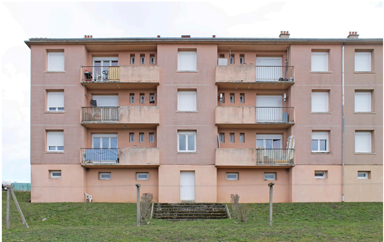
Sainte-Sigolène : les immeubles HLM de la Croix-Saint-Romain et le lotissement Les Érables, la façade postérieure du quatrième module du « Groupe 2 ».
