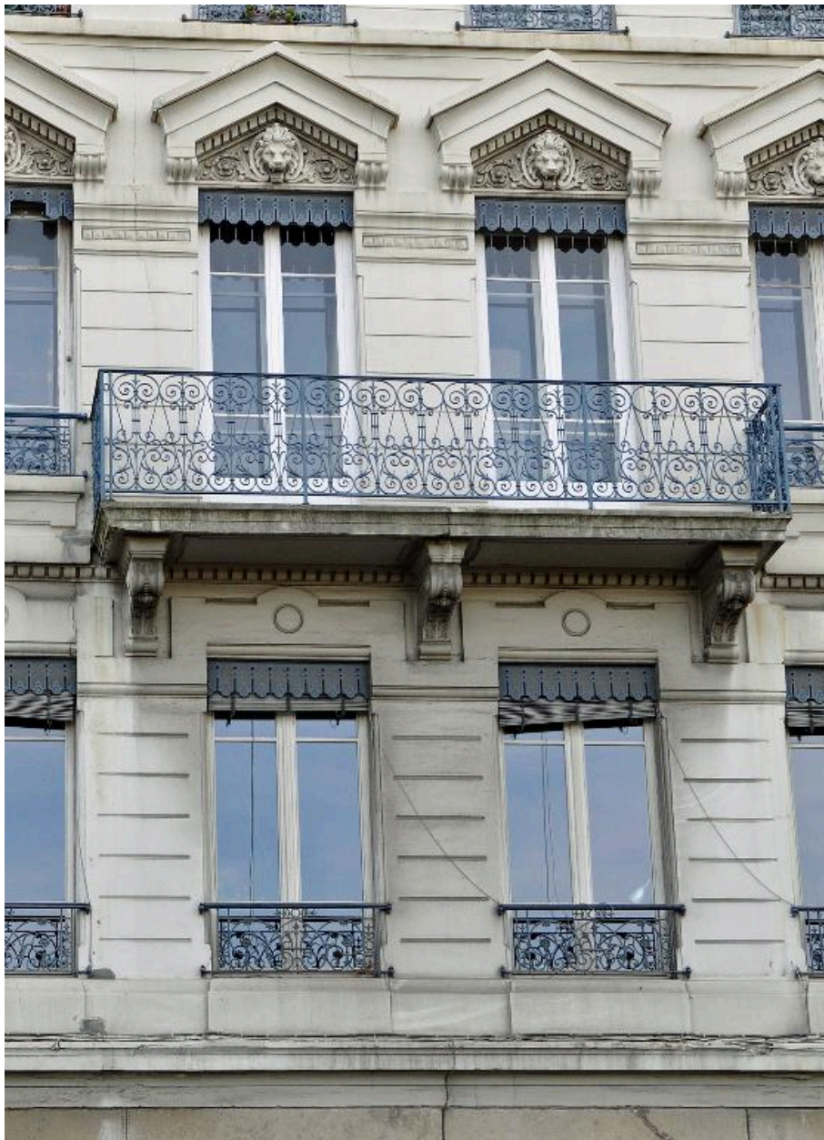
Vue rapprochée de l'élévation sur quai : décor des fenêtres du 2e et 3e niveaux
