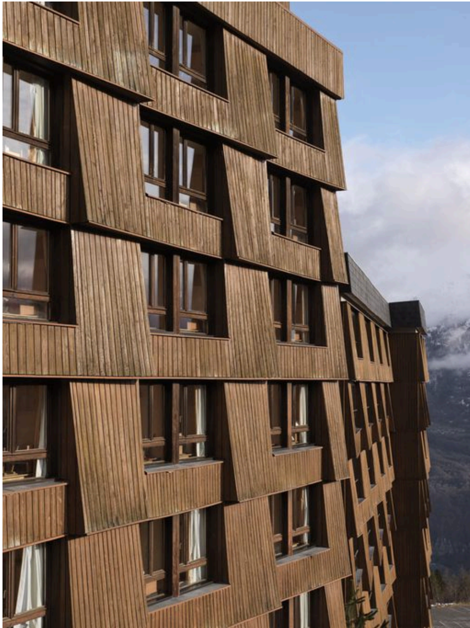
Détail de la façade sud
