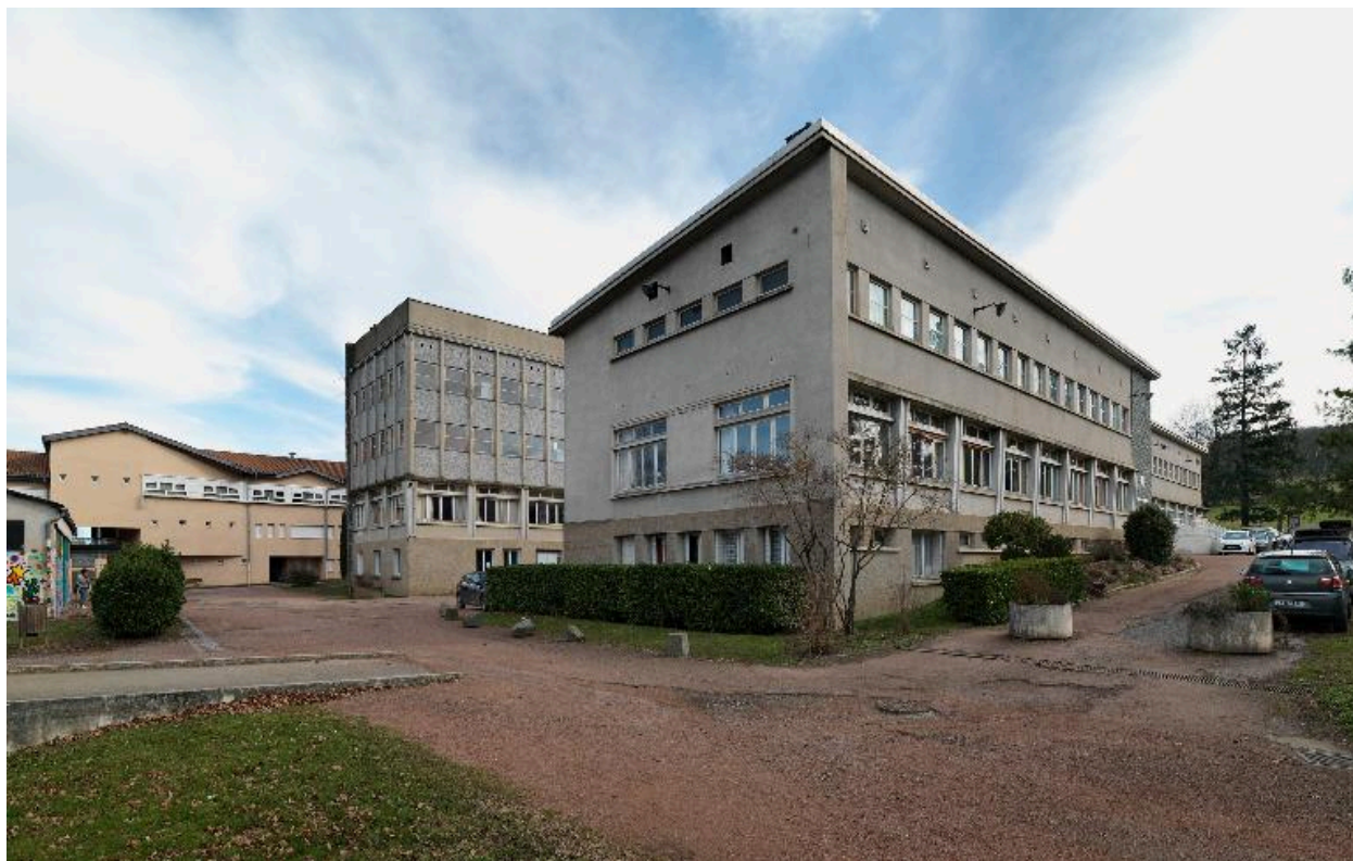
Bâtiment HI : vue d'ensemble depuis l'ouest
