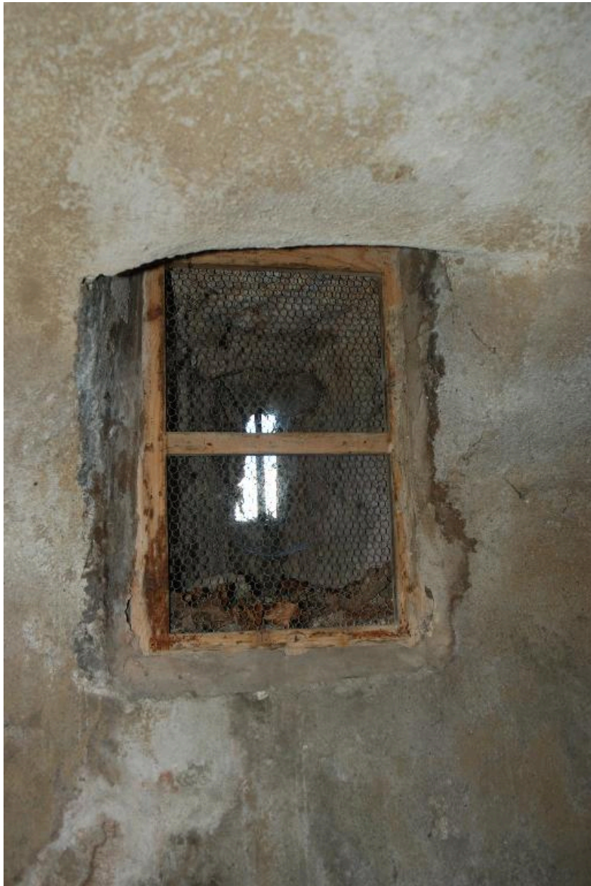
Rez-de-chaussée. Intérieur de la cave 2, étroit jour dans le mur nord.
