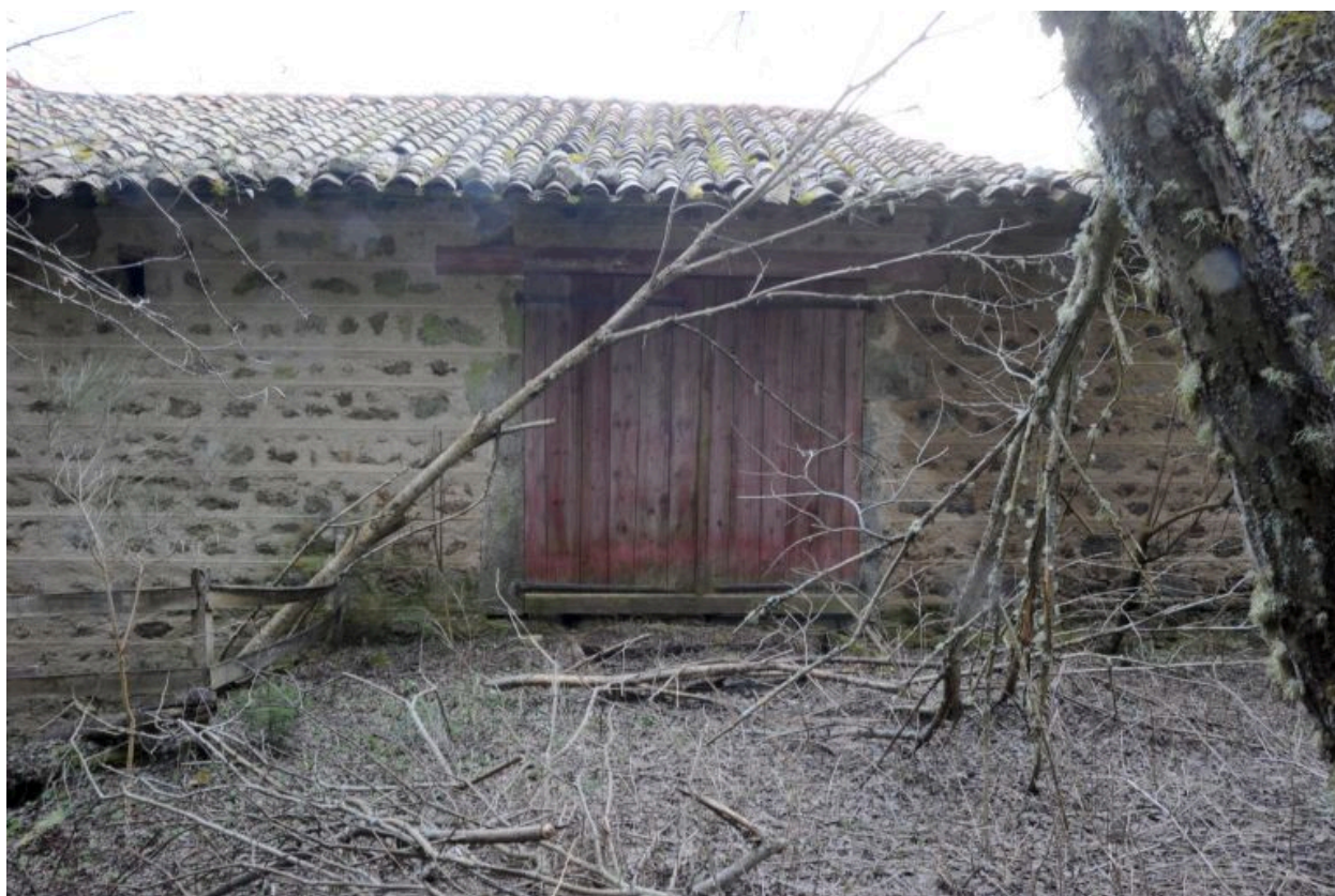
Vue partielle du mur gouttereau ouest.
