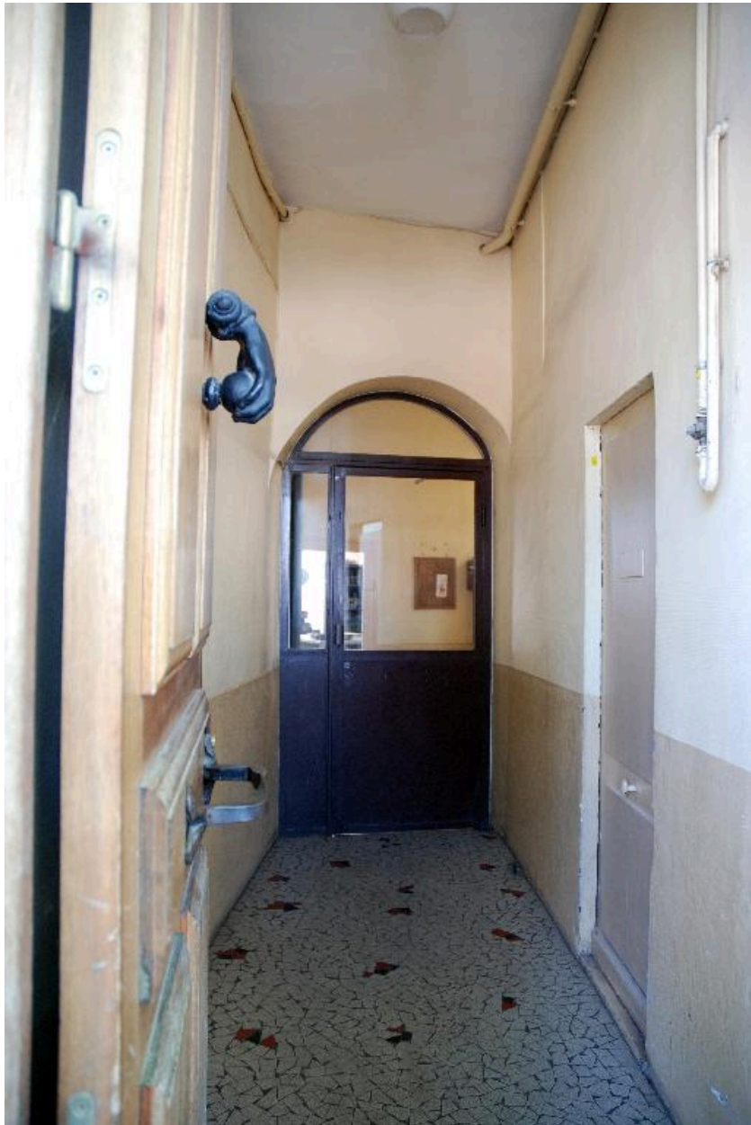
Porte d'entrée, couloir et vestibule-sas
