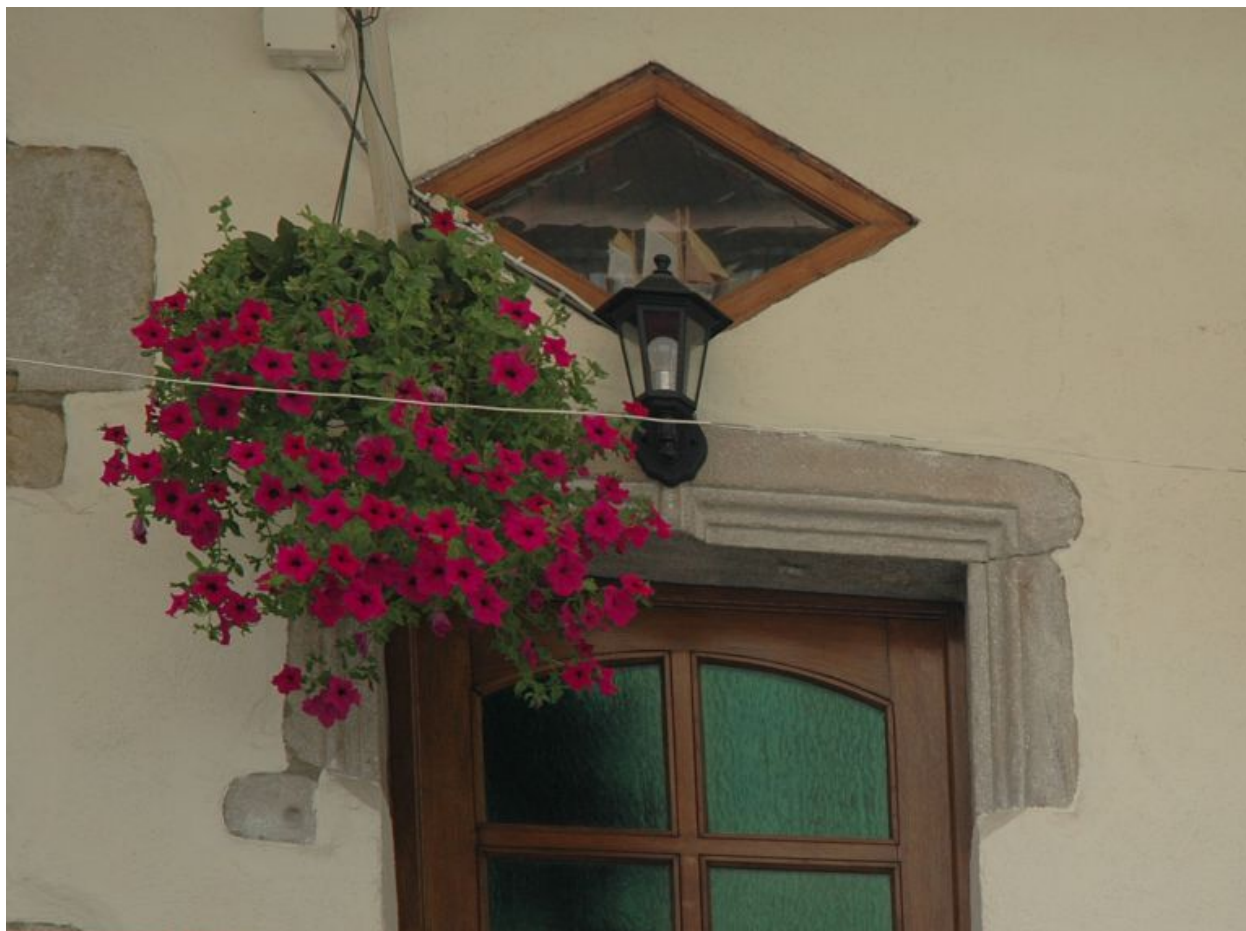
Vue partielle d'un linteau mouluré, ancienne fenêtre à meneau (17 e siècle), élévation postérieure, corps (A).
