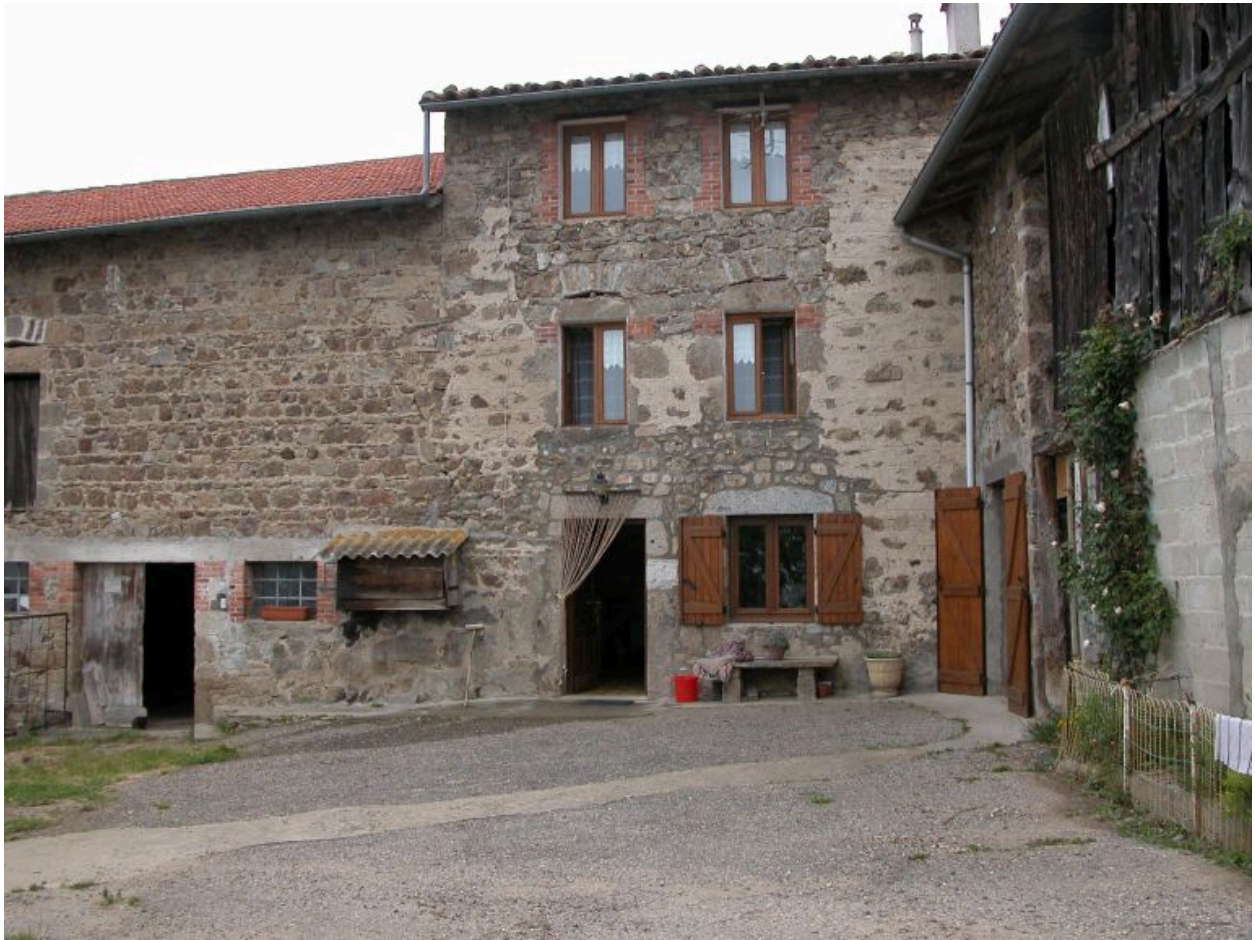
Pin (le) (1986 AC 384 à 388). Ferme, vue d'ensemble.
