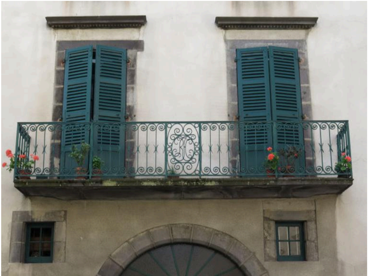
Portes-fenêtres et balcon au 1er étage
