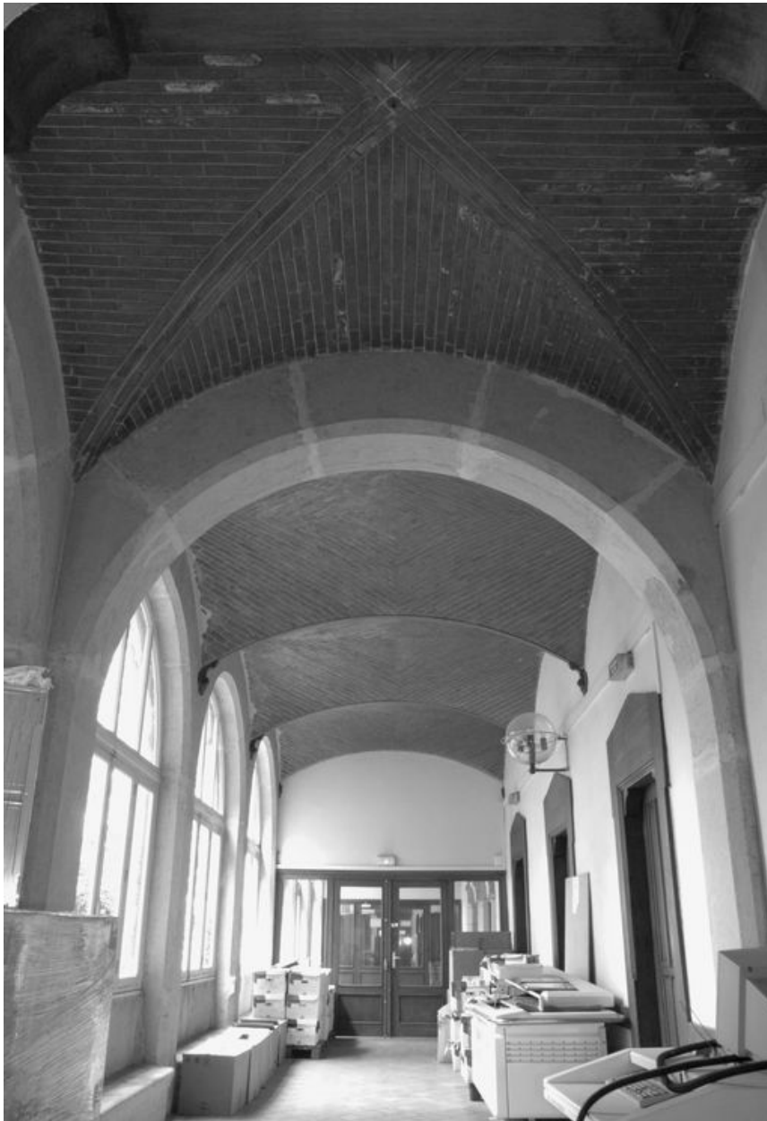
Galerie est du cloître, partie sud
