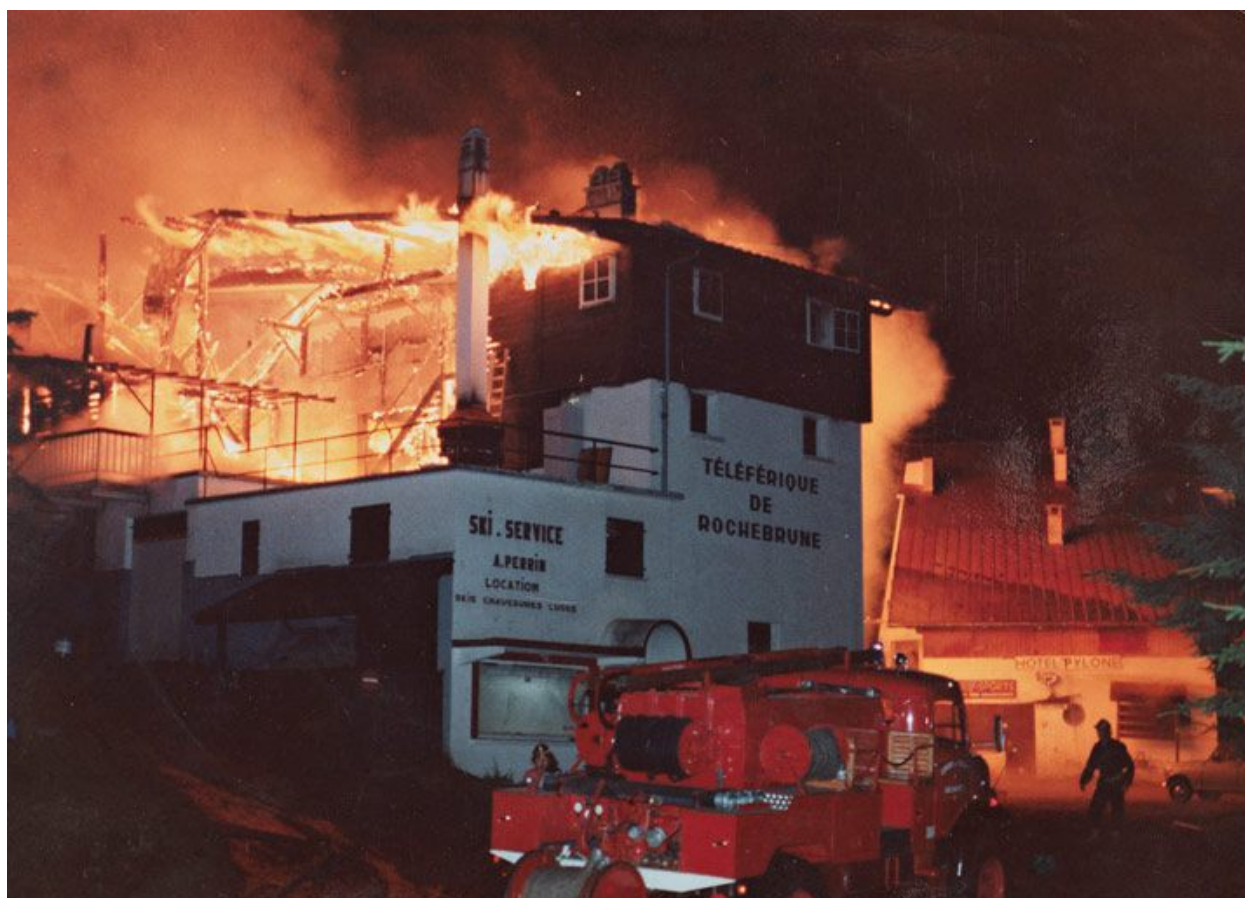
Gare inférieure. Incendie. Photogr. Service des remontées mécaniques. Megève
