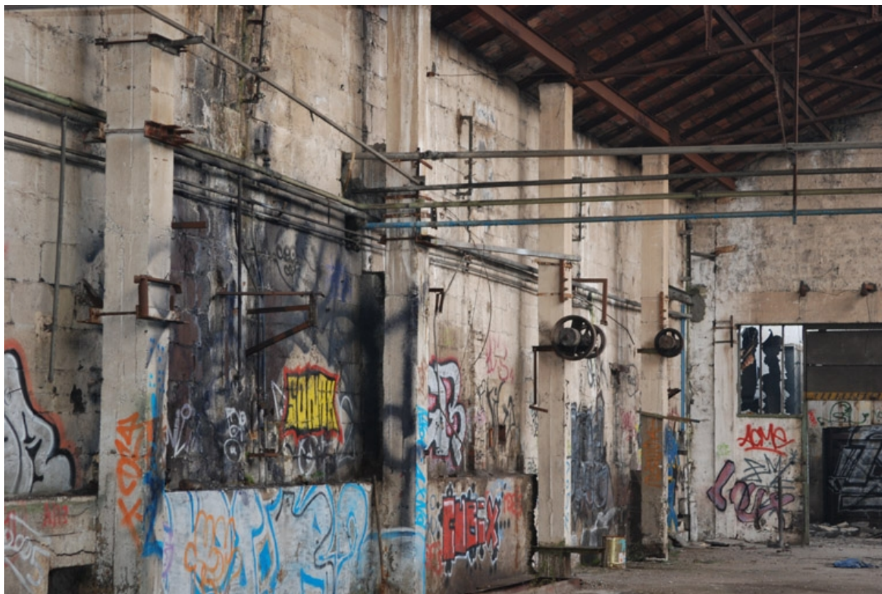
Vue d'ensemble atelier rez-de-chaussée
