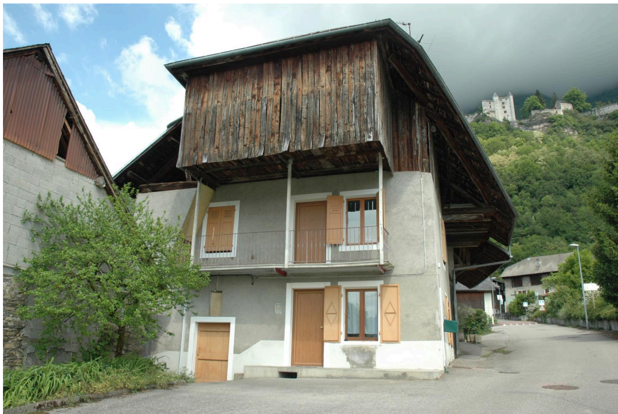
Ferme à bâtiments juxtaposés (2018 B 336, 337), habitation et extension du comble en charpente.
