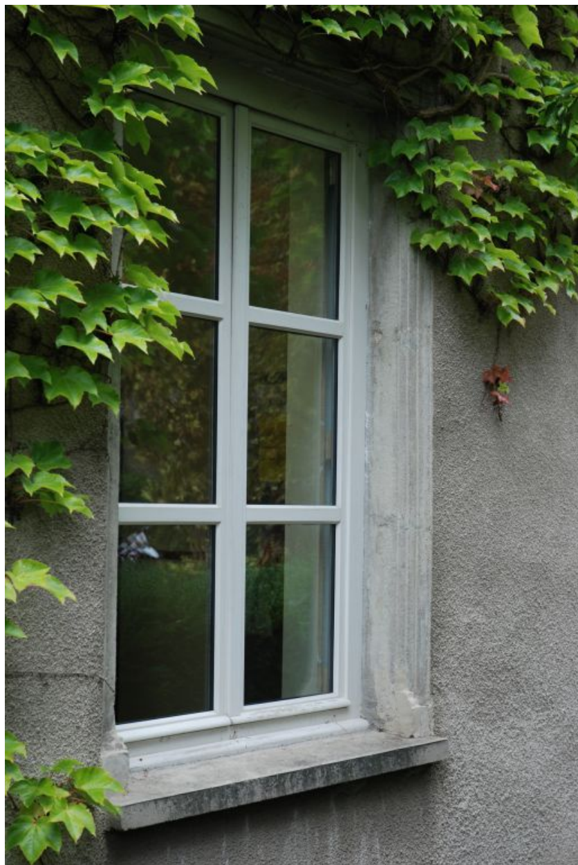
Embrasure à mouluration plate, détail d'un piedroit de fenêtre.
