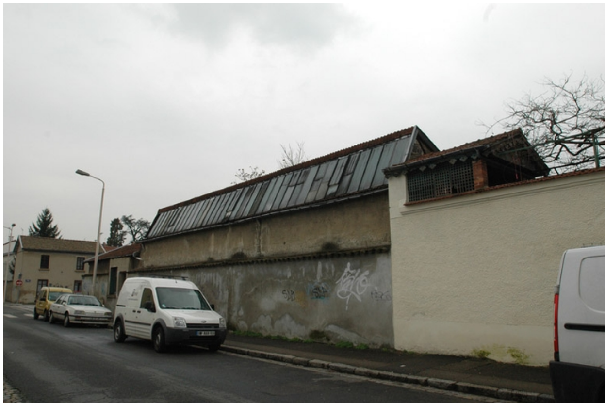
Façade extérieure vue ouest (shed)
