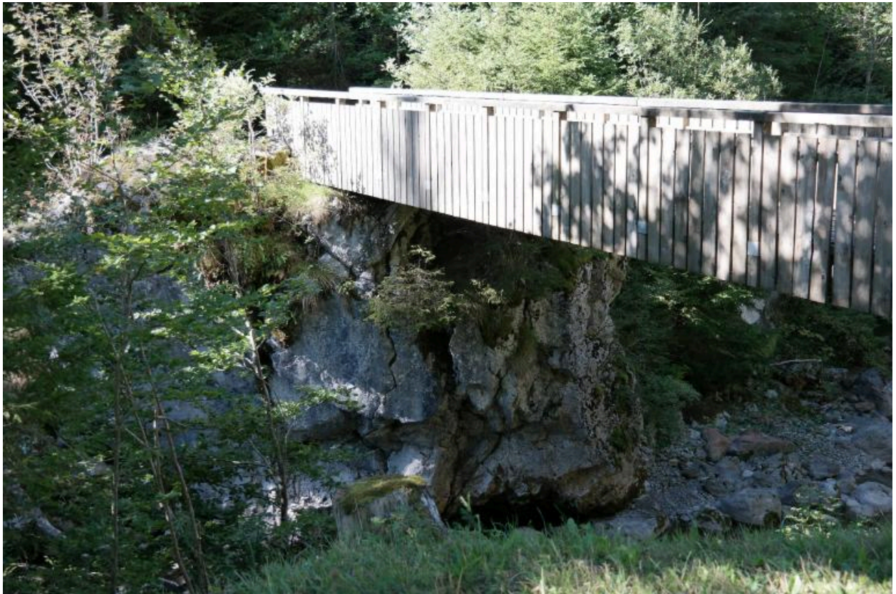
Passerelle de Porte, vue de la face amont
