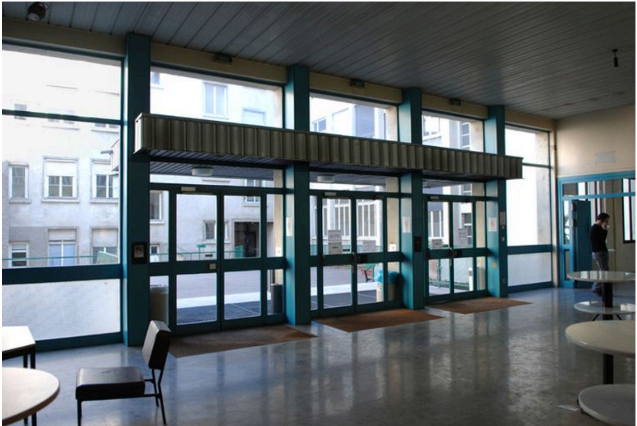
Bâtiment ISARA (2n tranche), porte d'entrée, depuis l'intérieur
