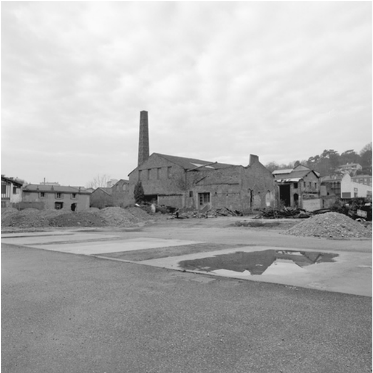
Vue générale sud-ouest, rue Marietton
