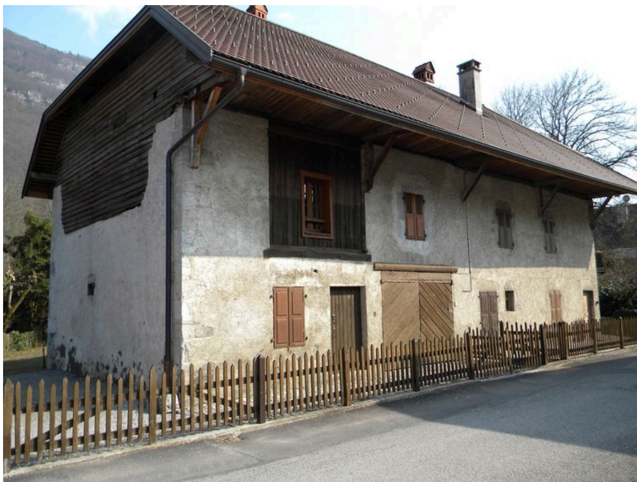
Vue de la façade principale en pignon nord.
