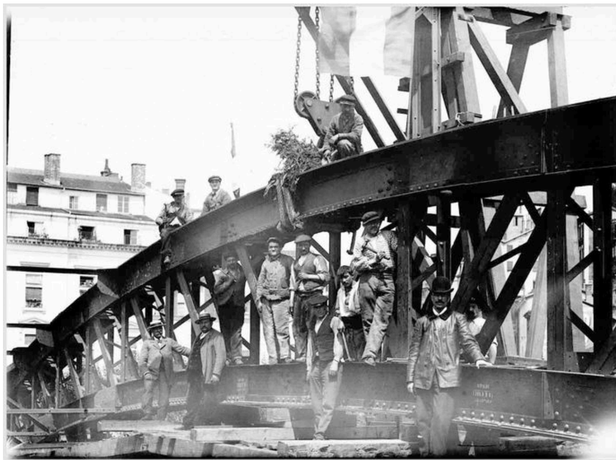
La construction du pont de la Boucle. La fin de la construction des arches. [1903]. 1 photogr. : n. et b. (AM Lyon. 15 Ph 1829)
