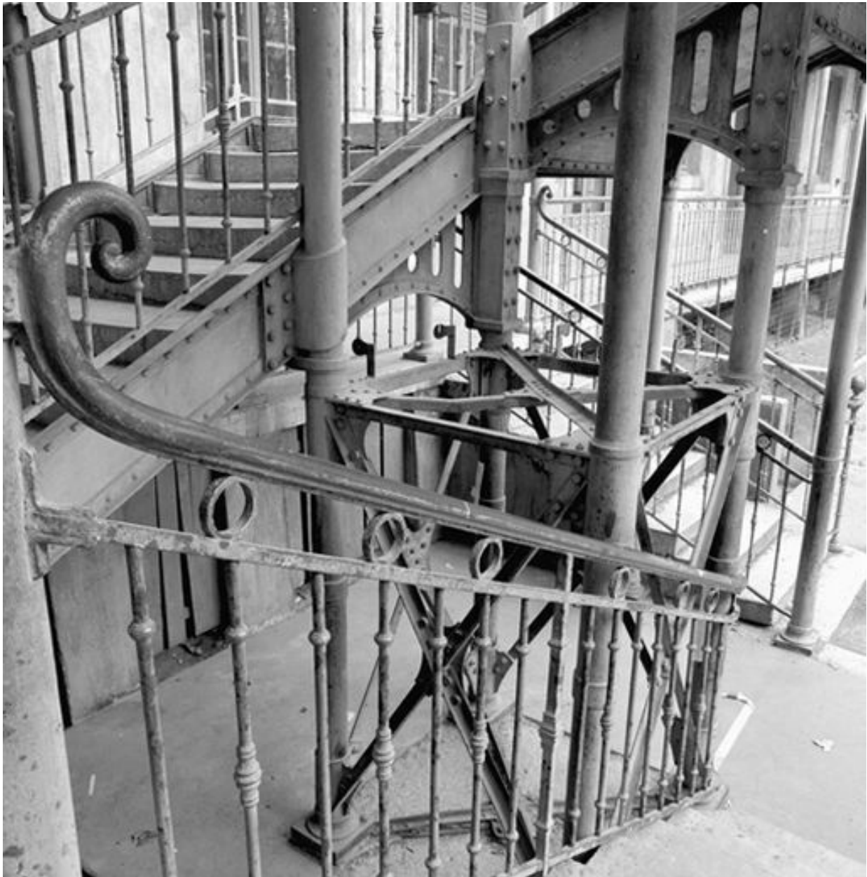
Ecole Ozanam, escalier hors-oeuvre de la cour : partie centrale
