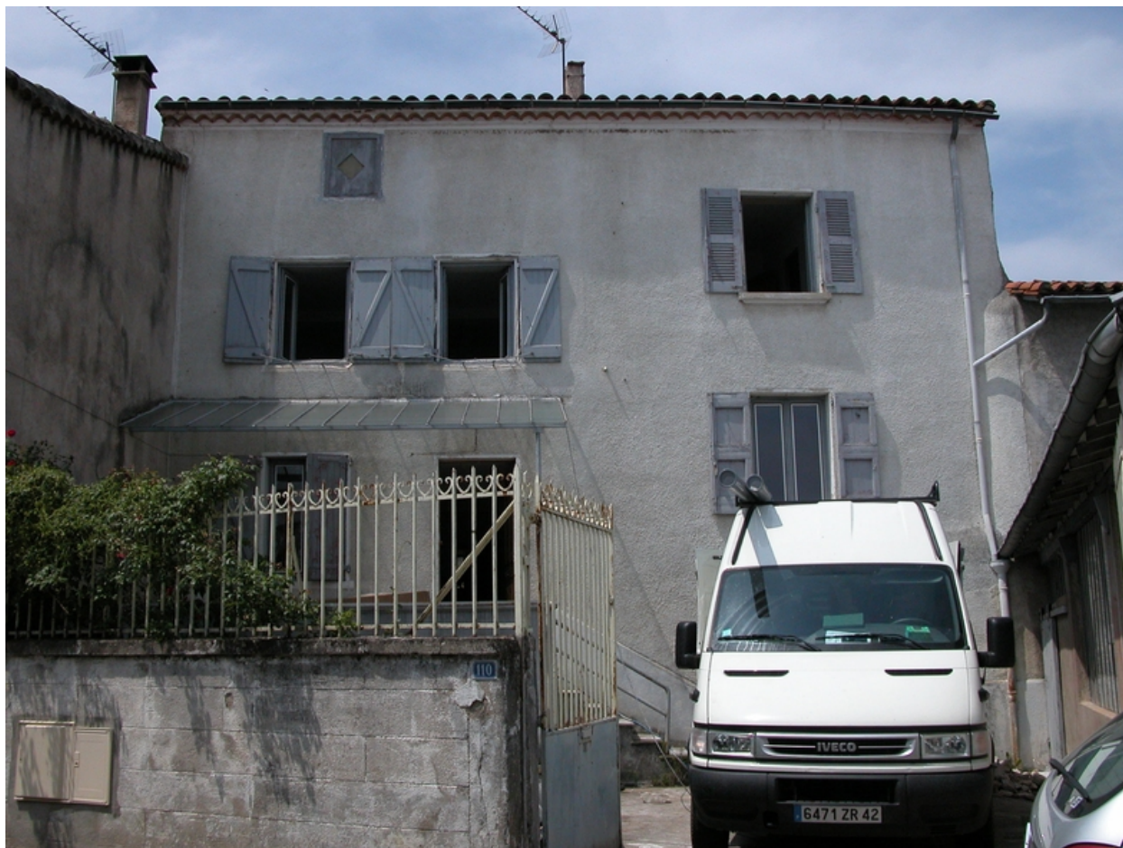
Faubourg de la Sablière. Maison et atelier d'artisan (1999 AB 126, rue de l'Arzalier).
